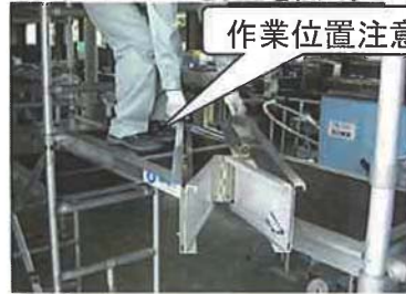
7.可動側スツパー左右解除する。可動側のスツパー右解除
