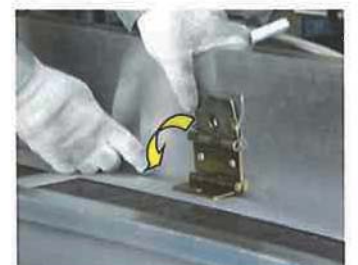
スツパー固定金具を床板に合す スツパー固定金具で固定
