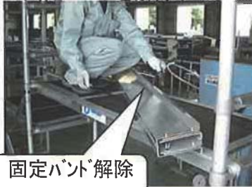
7.可動側スツパー左右解除する。可動側のスツパー右解除
